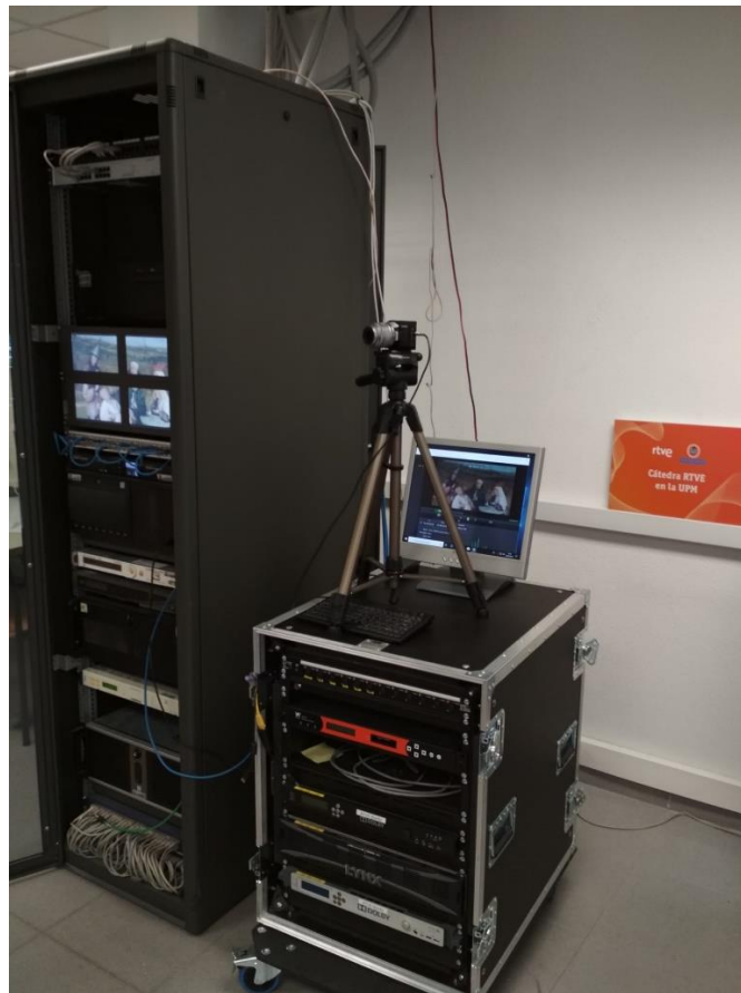
Figura 13. Cabecera de TV del GATV empleada para la emisión de contenidos audiovisuales
