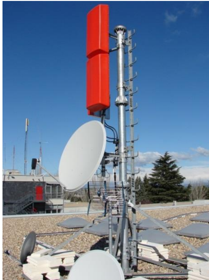
Figura 14. Sistema radiante empleado en las pruebas de emisión de DVB-T2 de la Cátedra
