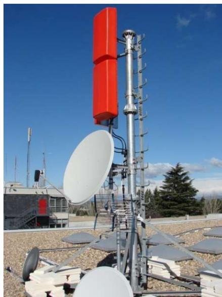
*Figura 10. Sistema radiante empleando en las pruebas de emisión de DVB-T2 de la Cátedra*
