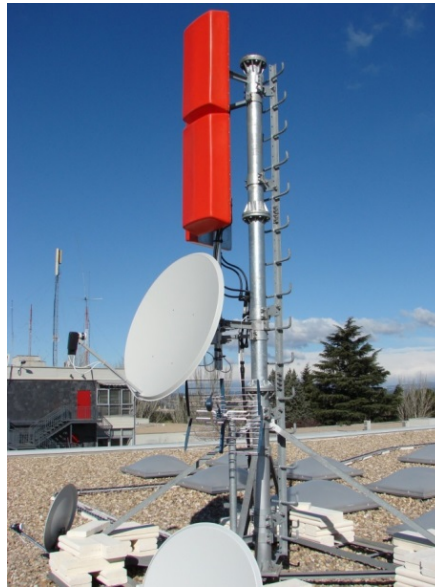
Figura 13. Sistema radiante empleando en las pruebas de emisión de DVB-T2 de la Cátedra
