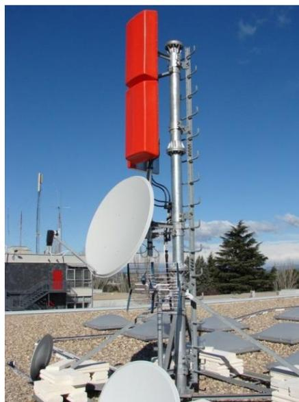
*Figura 16. Sistema radiante empleando en las pruebas de emisión de DVB-T2 de la Cátedra*
